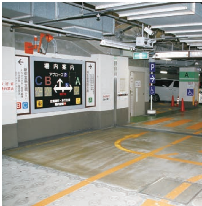
駐車場管制設備（料金精算システム・車路管制システム）
