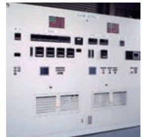
医薬品製造監視盤
