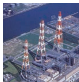
電力会社発電所
