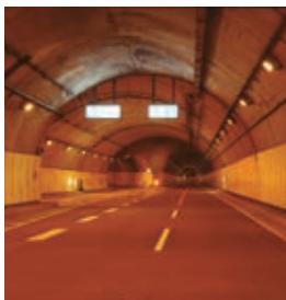
阪神高速 32号新神戸トンネル
